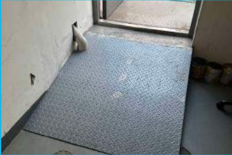
▼ 於 7F 階梯設置鋼板斜坡避免搬遷重物危害
